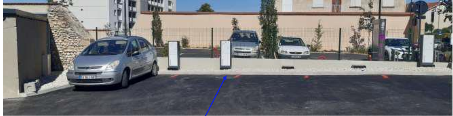
Pose du réseau souterrain pour places ouvertes avec mobilier de recharge
