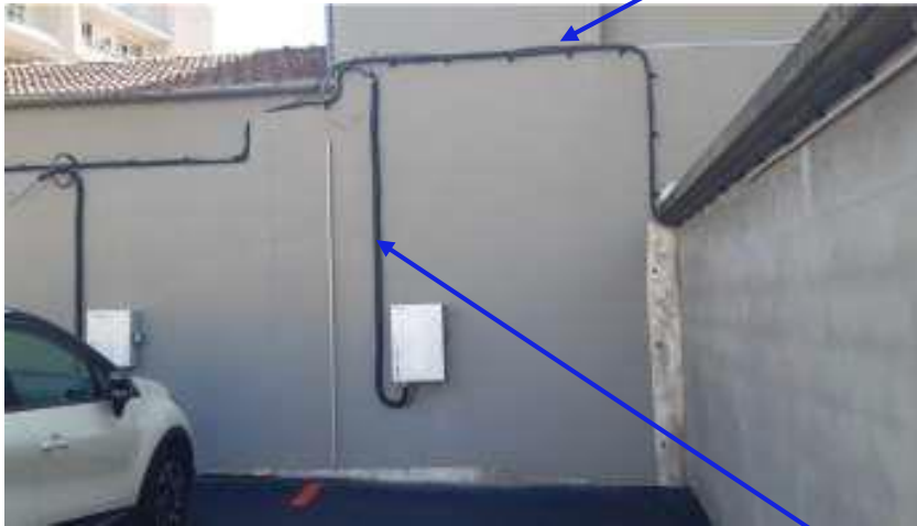
Pose du réseau sur façade
